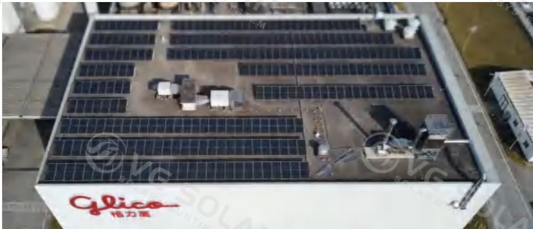
上海格力高 1MW 1MW - Shanghai,China
