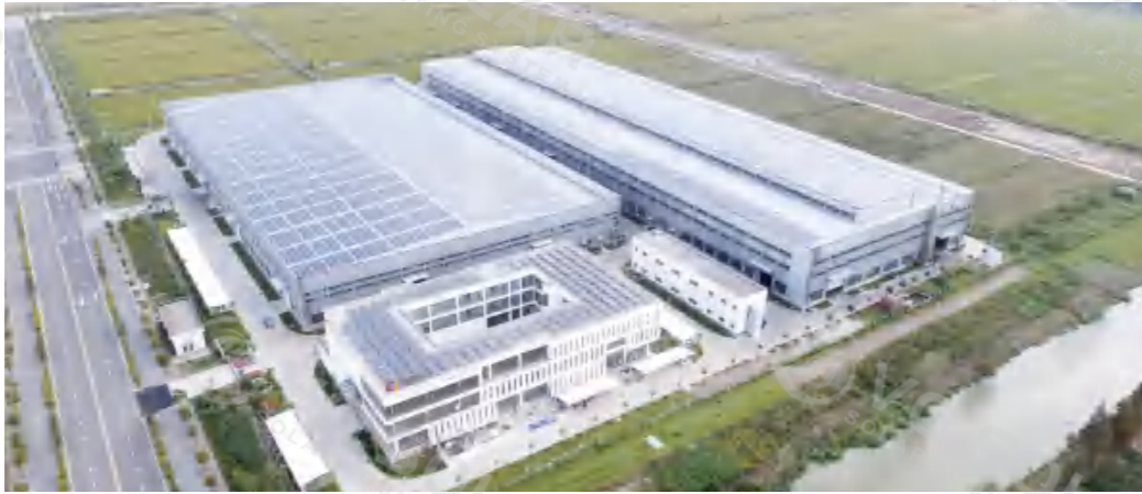
上海昌强重工 4MW 4MW - Shanghai ,China
